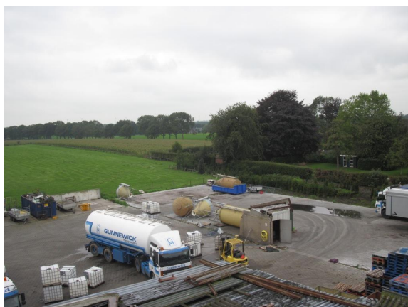
Het lichte betegelde terrein is het grondplan van de door storm verwoeste loods. De nieuwe grote loods wordt bijna twee keer zo lang en in de richting van de es uitgebreid. Daarachter staan op de begraafplaats meerdere hoge bomen, waaronder enkele monumentale.
