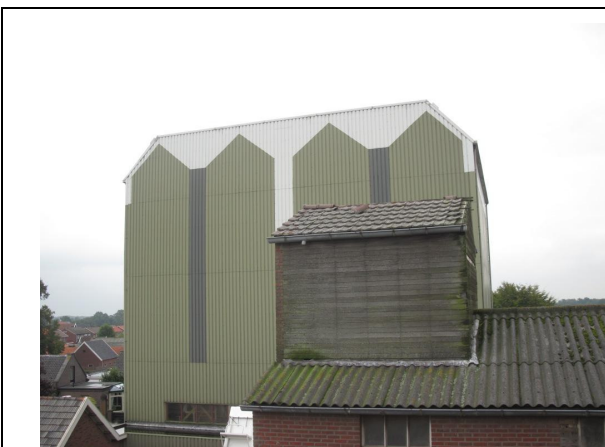
De windvang uit de sector oostnoordoost – oostzuidoost is verloren gegaan door de plaatsing van een zeer hoge silo op 25 meter afstand van de molen. Voor het mengvoederbedrijf noodzakelijk, voor het maalwerktuig zeer ongunstig.
